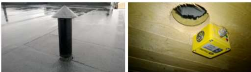
Figur 1.11 Ventilation av det kalla taket, (Kurkinen, 2014).
